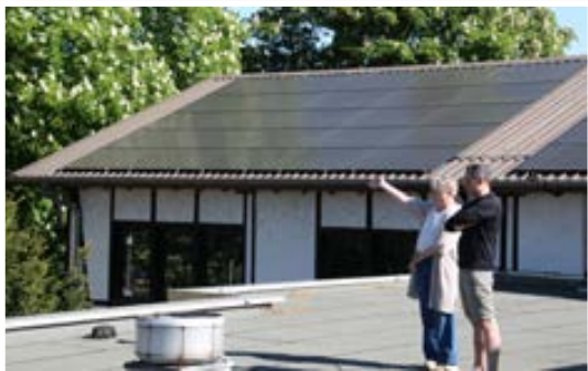
Nicoline Pilz von der RNZ mit Markus Ding auf dem Dach der Jahnhalle vor der Photovoltaikanlage
